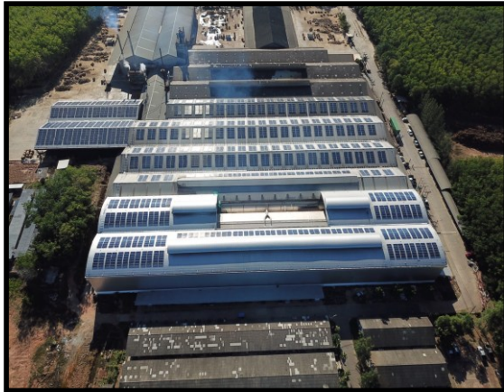
Woodwork Angsuthon Branch ( Satun Province ), ขนาดติดตั้ง 986 kWp.
