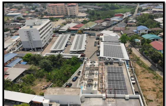
Kasemrad Hospital Saraburi, ขนาดติดตั้ง 307 kWp
